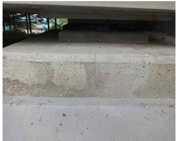
받침장치 02 A2 SH1 받침콘크리트 균열 (cw=0.3mm)
