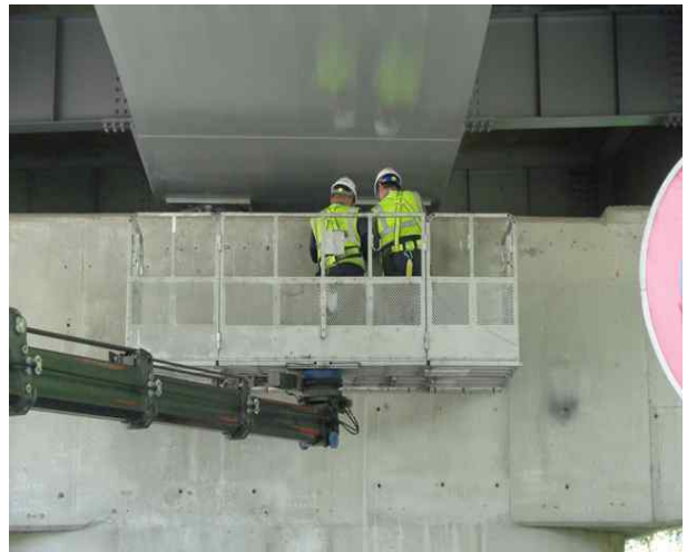
교량점검차를 이용한 근접조사
