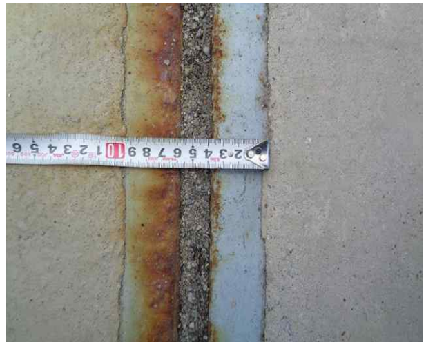
신축이음 유간 측정
