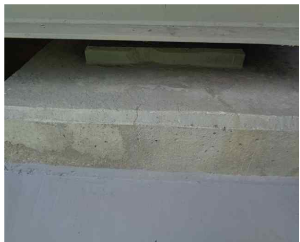
받침장치 06 A2 SH6 받침콘크리트 균열 (cw=0.3mm)
