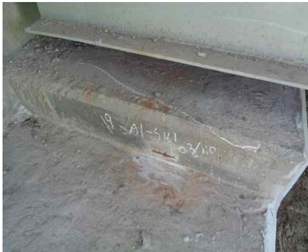
받침장치 01 A1 SH1 받침콘크리트 균열 (cw=0.3mm)
